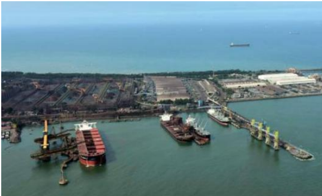
Figura 3 Terminais de Granéis Líquidos
