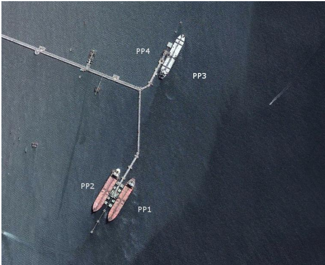
Figura 5 TEBIG (área de estudo) com uma embarcação tipo VLCC atracada no berço externo e outra do tipo Suezmax no berço interno
