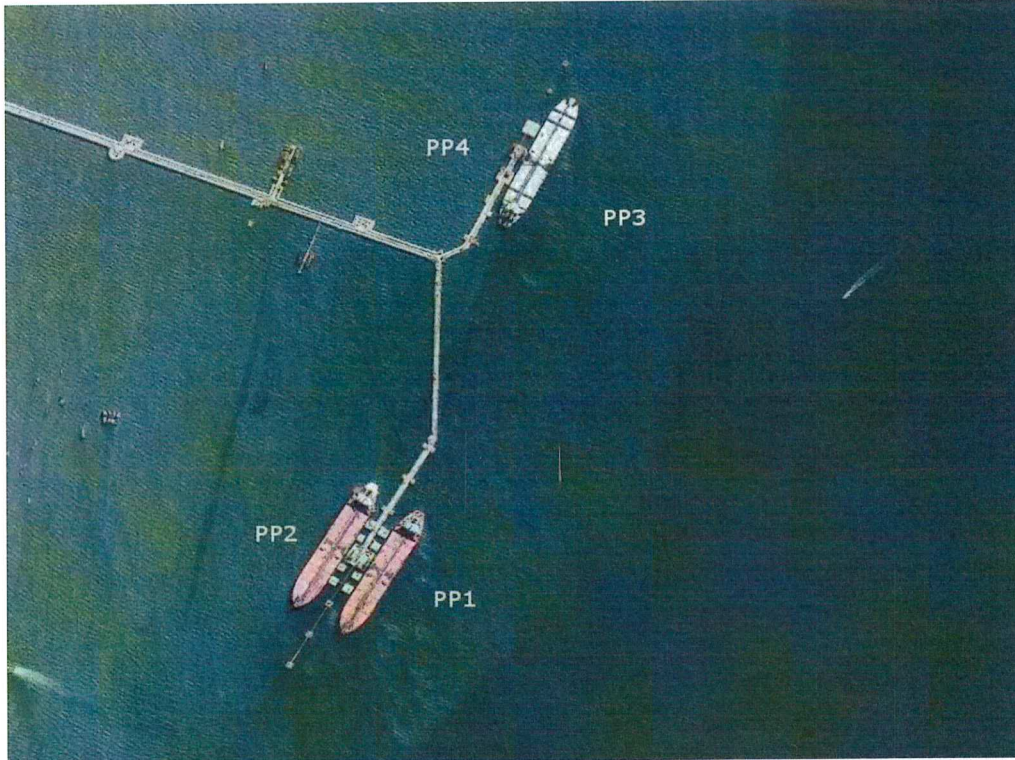
Figura 6 – Detalhes do pier Sul. Fonte: Google
