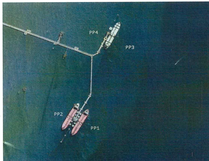
Figura 2 – Configuração de navios no TEBAR em operação a contrabordo
