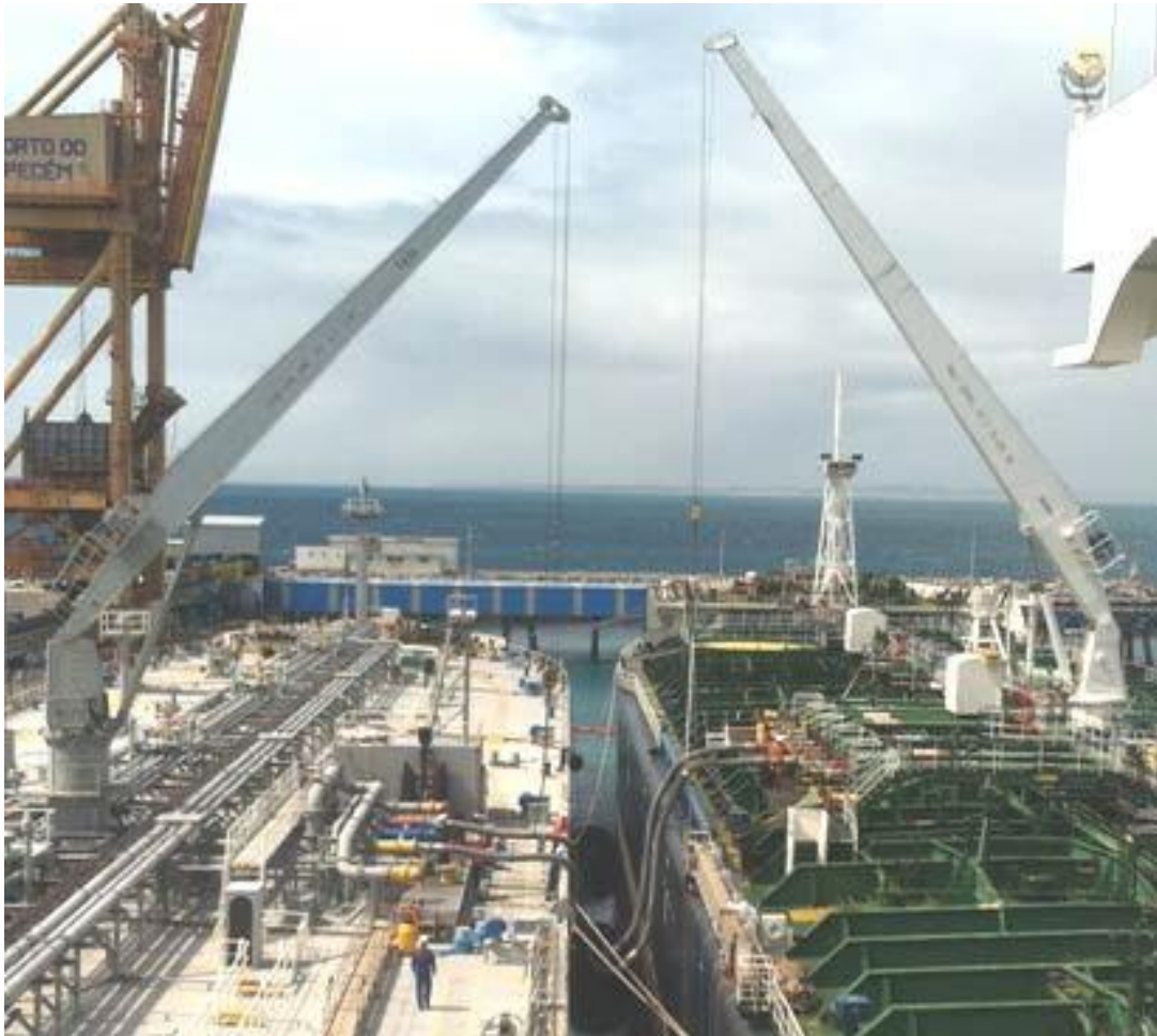
Fig.3 – Transferência por mangotes em STS atracado, em Pecém
