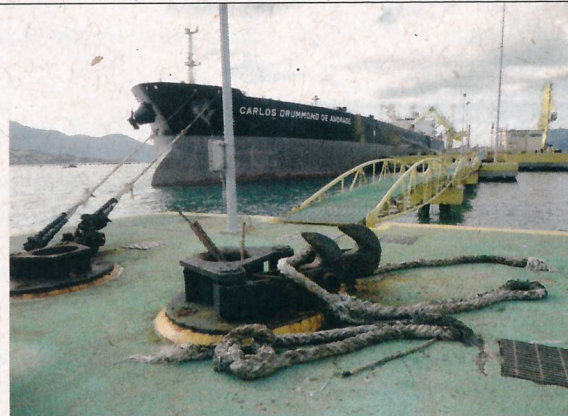
Em primeiro plano, gatos do Dolphin 13 com cabos rompidos. Ao fundo NT Carlos Drummond de Andrade atracado no Pier 3
