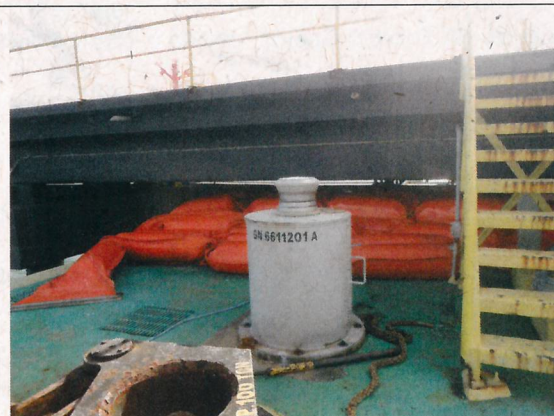
Barreiras de contenção em prontidão
