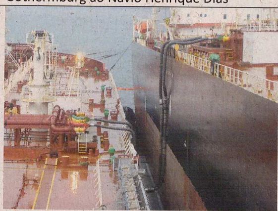
Detalhe dos mangotes de transferência
