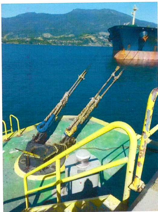
Figura 8 Cabos de aço de 42mm com calabotes empregadas no TEBAR para amarrar uma embarcação do tipo VLCC.
