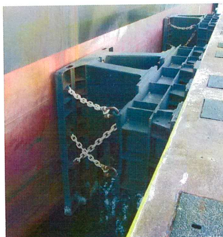
Figura 11 Defensas tipo Pi instaladas no PP4
